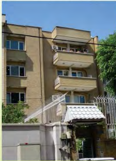
پروژه شرکت سرمایه گذاری بوعلی تندیس ترنم / تهران
