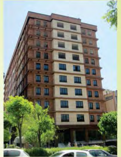
پروژه مجتمع تجاری اداری یوسف آباد / تهران
