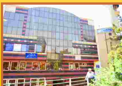
پروژه درمانگاه مسجد نور
