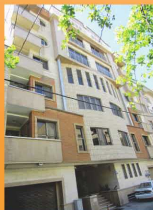
مجتمع مسکونی تورج
